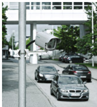
Das ANPR-Kamerasystem bietet eine breite Palette an Anwendungsmöglichkeiten: bei Geschwindigkeitsmessungen, bei der Reisezeitmessung sowie bei der Mauterfassung und bei Parkkontrollen und Sicherheitsanwendungen
